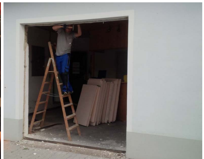
Umbauarbeiten im alten Zeughaus
